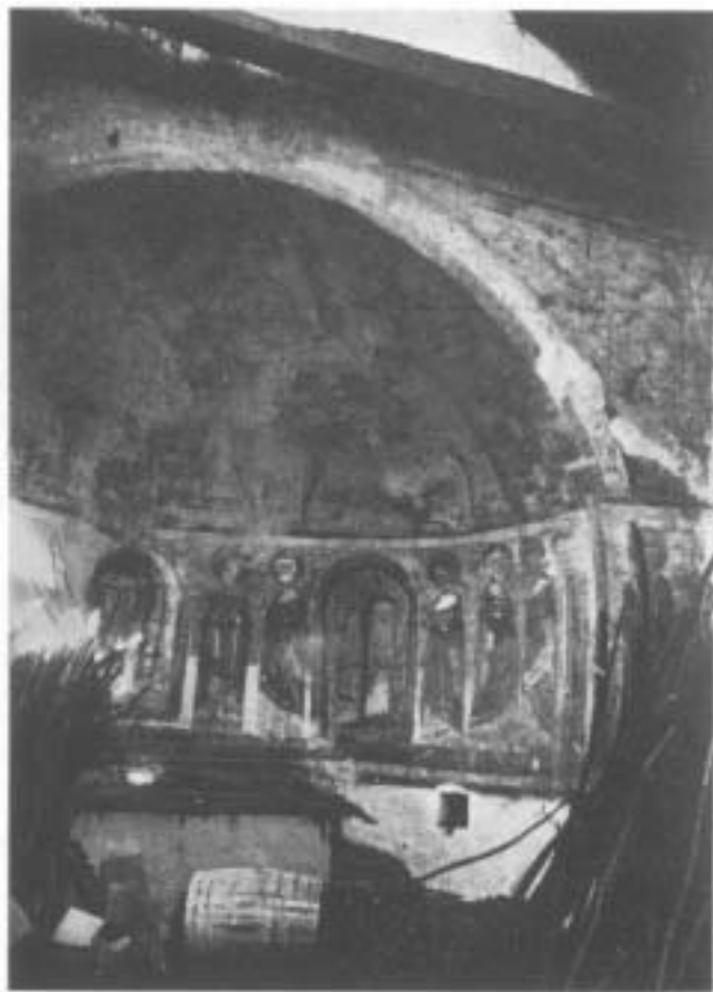
Fig. 237. - Briga - S. Tommaso - Interno prima del restauro
