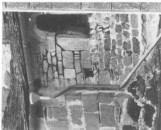
Fig. 246. - Isola S. Giulio - Muratura e finestra della navatella a giorno
