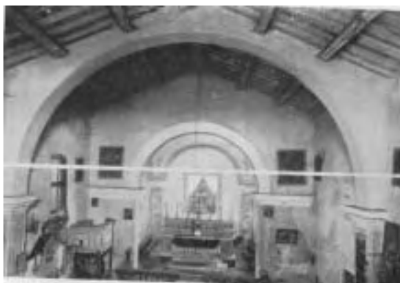
Fig. 158. - Sillavengo - S. Maria Vecchia - Interno
