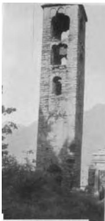
Fig. 157 – Villadossola - S. Maurizio al Piaggio - Campanile
