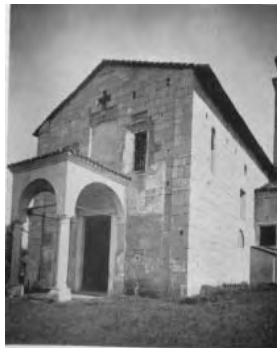
Fig. 144 - Conturbia - S. Giorgio - Facciata
