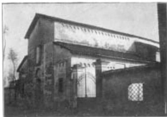
Fig. 13. - Casalino - S. Pietro - Facciata
