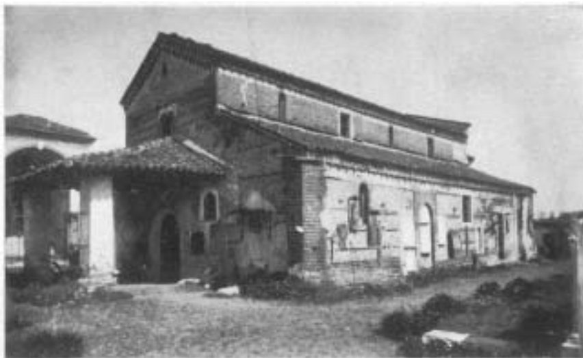
Fig. 268. - Briona - Chiesa del Cimitero - Facciata e fianco a giorno
